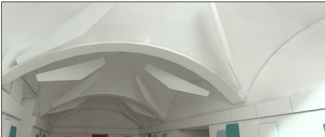
Figura 34. Proposta de millora. Panells fonoabsorbents del sostre.
